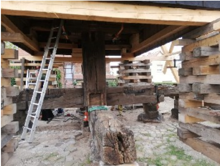
Bild 6: der angehobene Hausbaum gibt die Schwellen frei, die Bockstreben sind bereits herausgenommen
