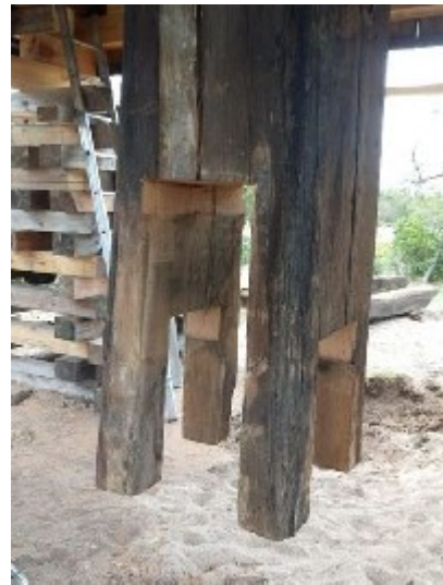
Bild 7: der frei „schwebende“ Hausbaum nach Herausnahme der Bockschwellen
