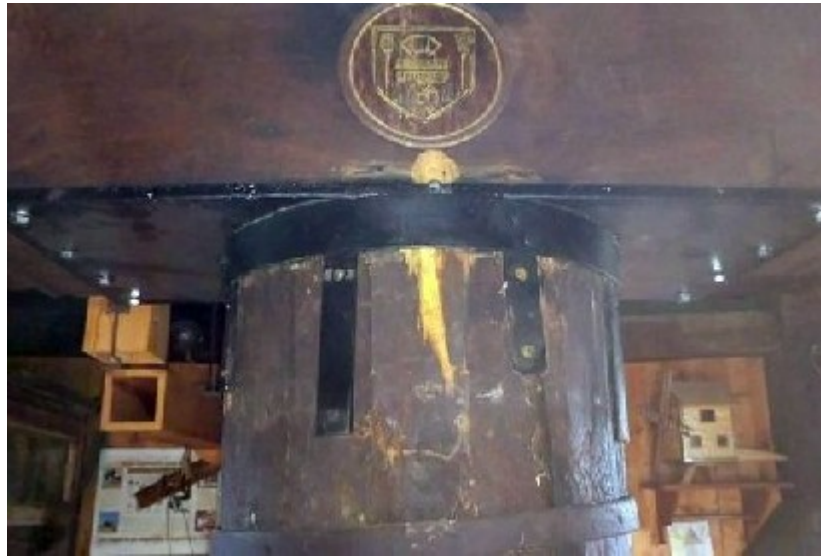
Bilder 12 und 13: Die Mühle steht wieder auf eigenen „Füßen“, der stabilisierte Zapfen ist frisch abgeschmiert.
