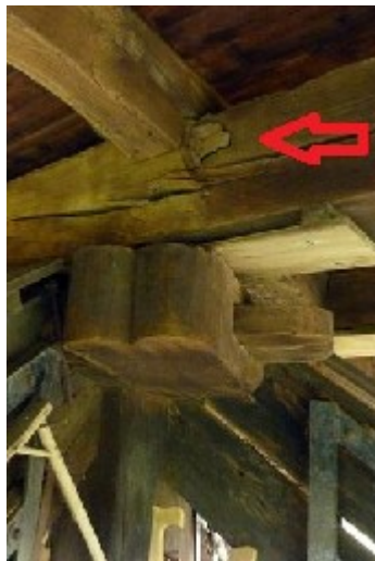
Bild 2: angebrochener Fugbalken
