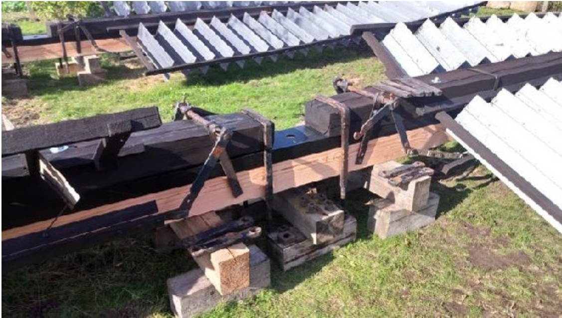
Bild 15: Bruststücke und Flügel wurden schon einmal am Erdboden montiert, um die Flügelpaare auswuchten zu können
