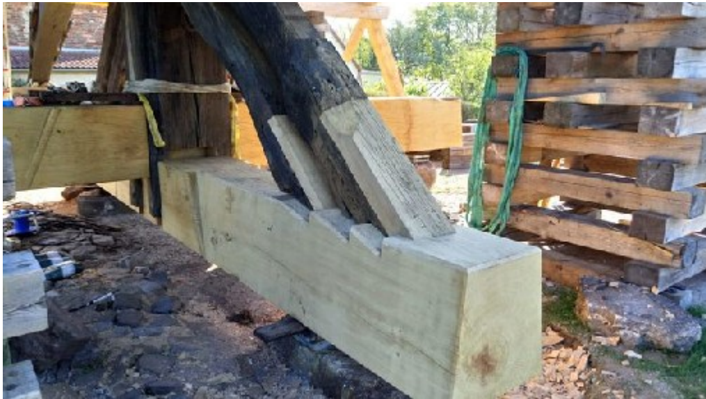
Bild 10: die neuen Schwellen sind bereits montiert, die Streben wurden z. T. repariert und wieder eingesetzt
