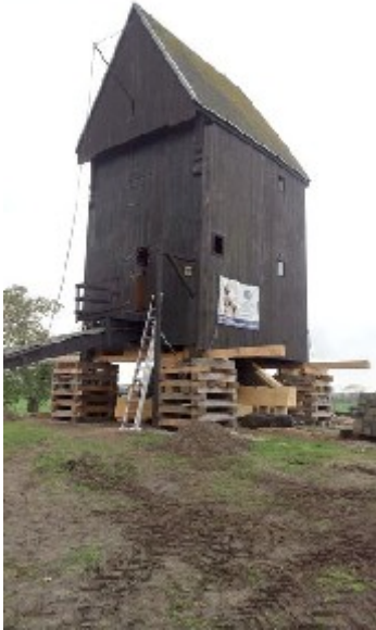
Bilder 12 und 13: Die Mühle steht wieder auf eigenen „Füßen“, der stabilisierte Zapfen ist frisch abgeschmiert.
