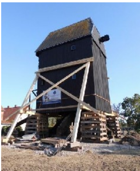
Bild 4: die abgestützte Mühle beim Anheben
