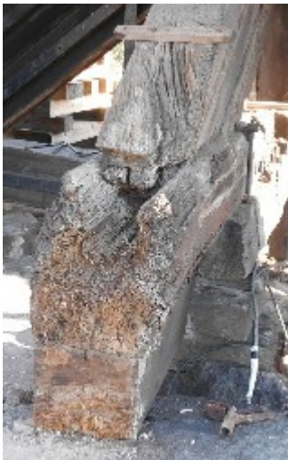
Bild 1: zerstörter Schwellenkopf
