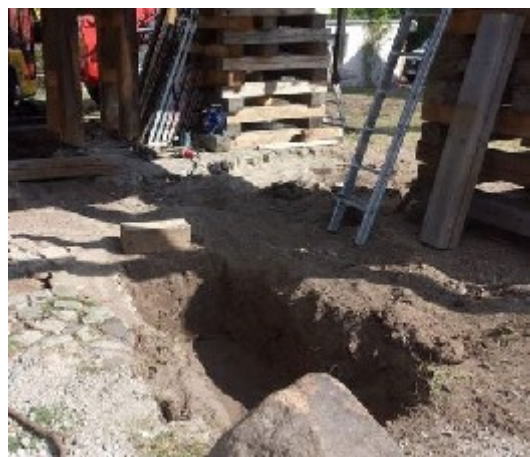
Bild 9: Fundamentarbeiten unter den Schwellen
