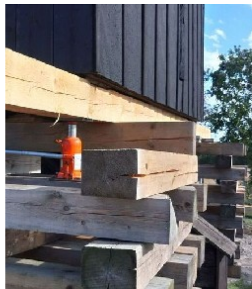
Bild 5: Detail: eine der vier hydraulischen Winden
