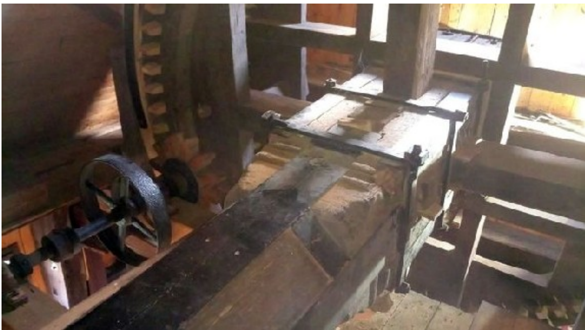
Bild 15: die marode Flügelwelle mit ihrem eisernen „Stützkorsett“
