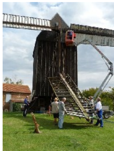
Bild 3: Abbau des Flügelkreuzes
